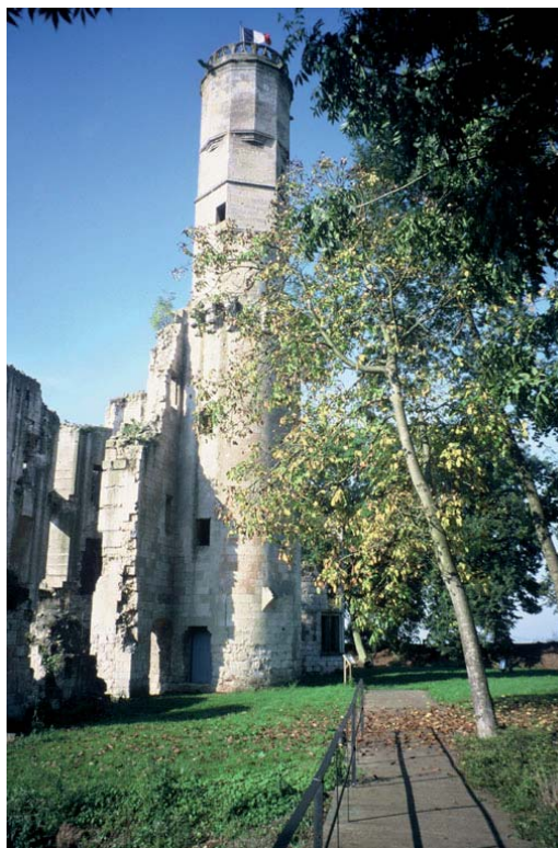
La tour de Folleville de base circulaire, puis hexagonale et dodécagonale, d'inspiration italienne, construite vers 1480
