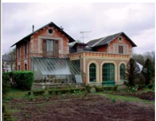
L'orangerie en restauration
